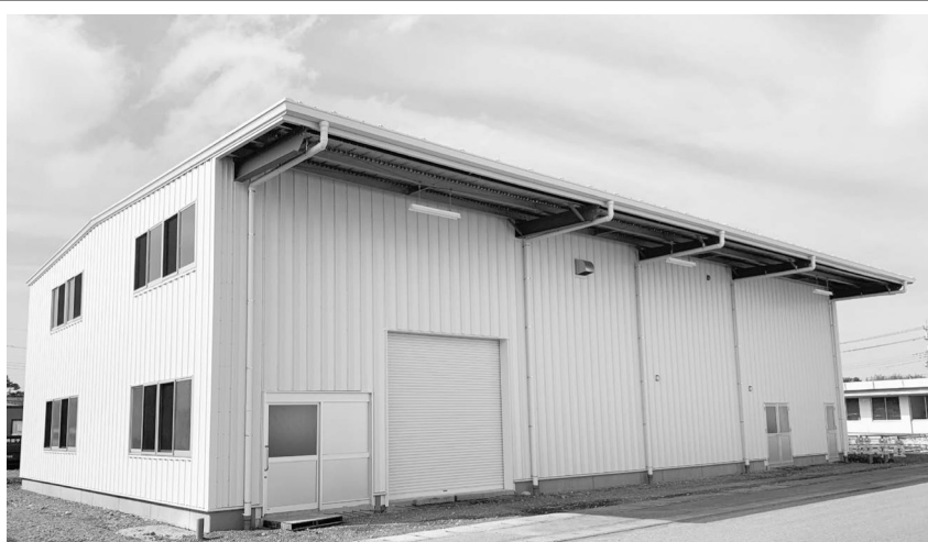
新光電子の新しい工場棟
